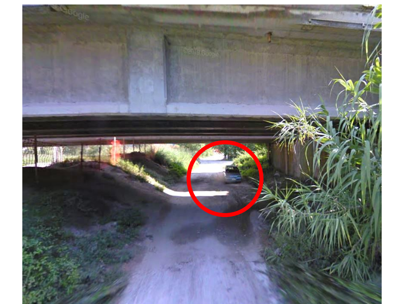
SOTTOPASSO AUTOSTRADA: PERCORSI PEDONALI LUNGO FOGLIA (24)
