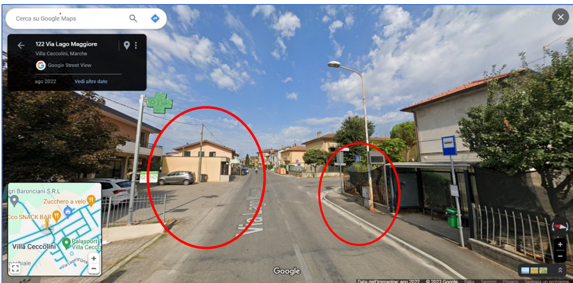
Figura 24. Villa Fastiggi – Villa Ceccoli, Località Villa Ceccoli, Via Lago Maggiore. Si segnalano i pericoli all’accesso della farmacia.
