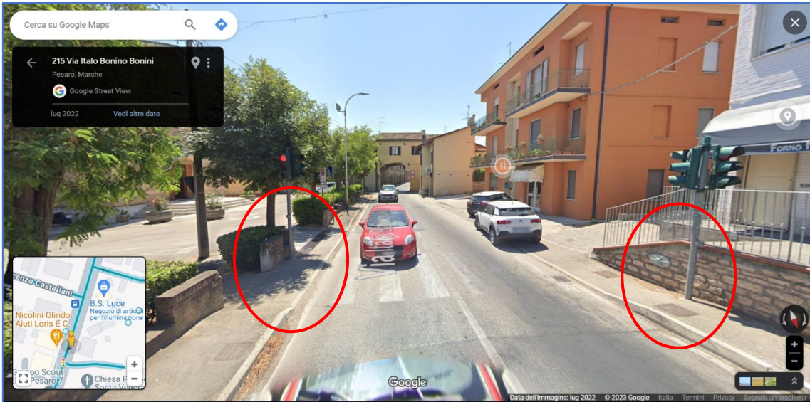
Figura 22. Quartiere Cinque Torri - Santa Veneranda, Via Italo Bonino Bonini – Si segnala l’attraversamento semaforico con semafori in aderenza al bordo del marciapiede, privo di guide e segnalazioni, sia orizzontali che verticali e di illuminazione, con sporgenze agli sbarchi
