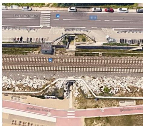
Figura 45. Sottopasso pedonale della ferrovia in prossimità di Strada delle Marche-Air Fly Club
