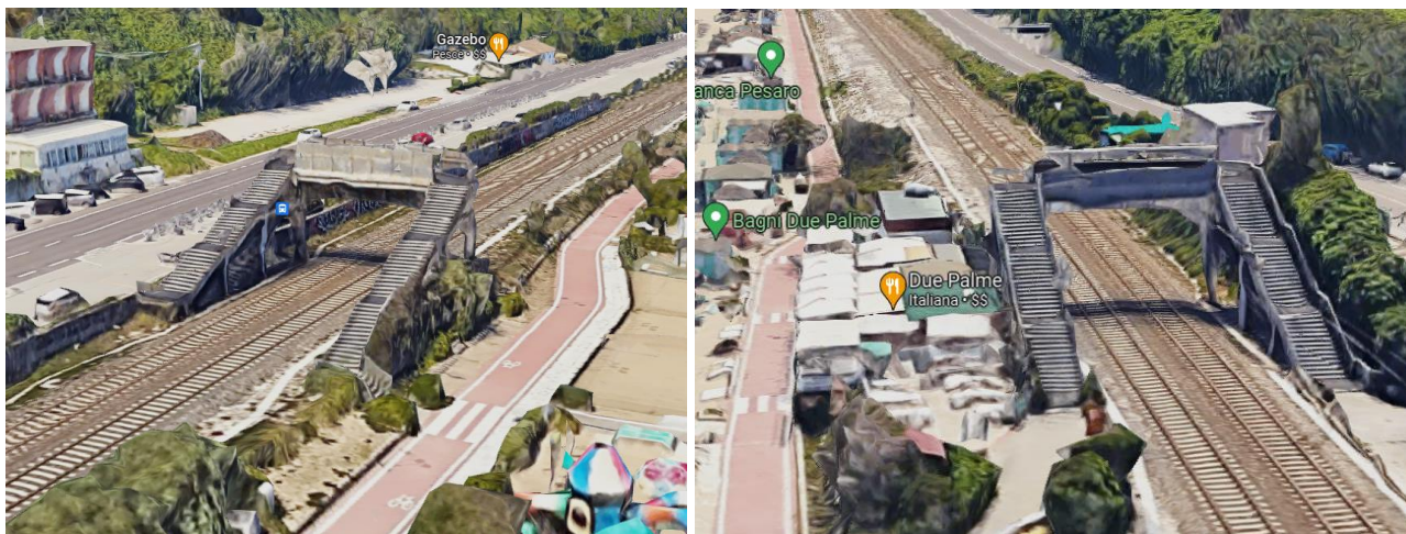
Figura 44. Ponti pedonali sulla ferrovia in prossimità di Strada delle Marche-Miramare Beach (a sinistra) e Strada delle Marche-Bagni Due Palme (a destra)
