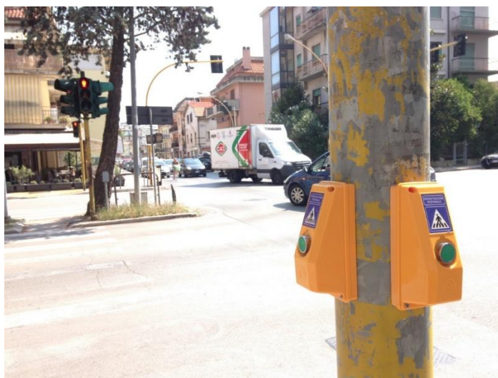
Figura 13. Pulsanti di prenotazione pedonale in Braille installati a San Benedetto del Tronto
