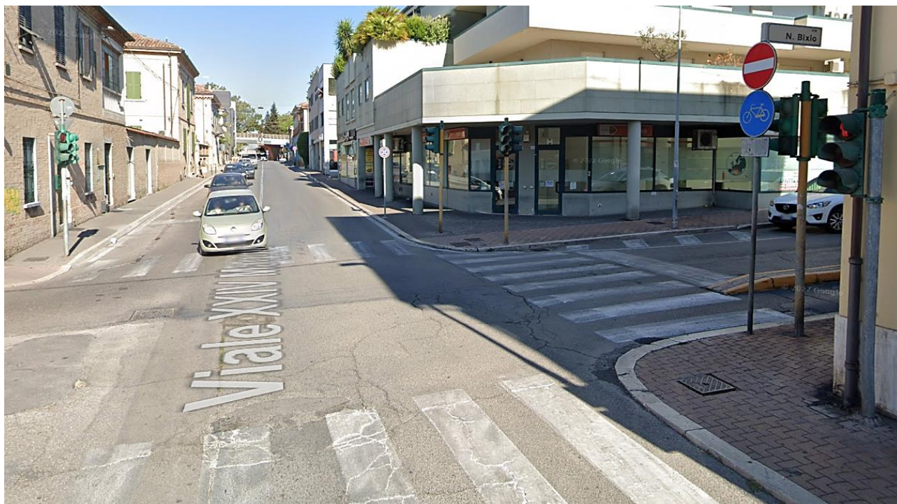
Figura 41. Impianti semaforici per attraversamento pedonale presso l'incrocio tra Viale XXIV Maggio e Via Bixio
