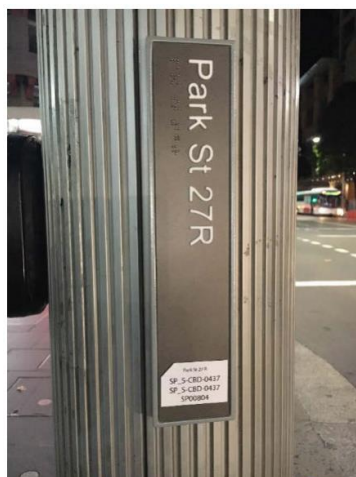
Figura 10. Segnaletica in Braille (formato 2)
