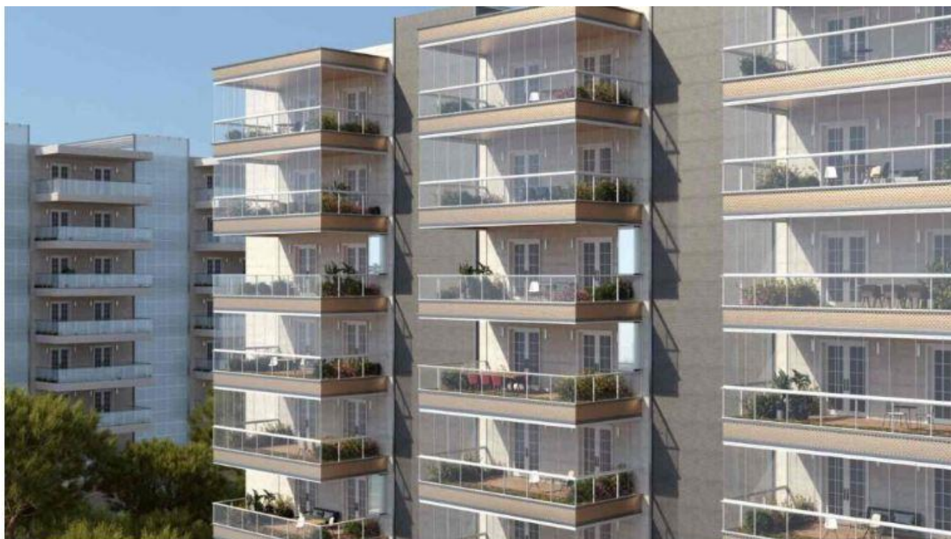
Esempio di installazione in un condominio
